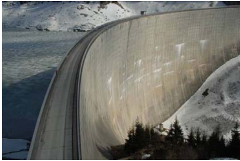
Figura 191: Presa de almacenamiento Kops en Austria
