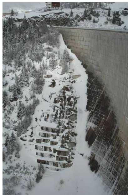
Figura 196: Parte izquierda de la presa, febrero 2007
