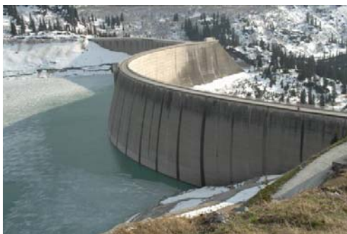
Figura 192: Presa de almacenamiento Kops en Austria
